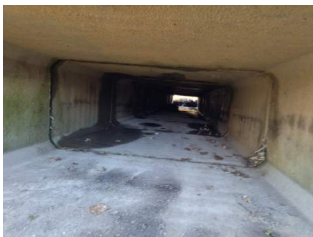
Section du Nord au Sud du dalot sous la RD67 (crédit photo : Étienne Boissy)
