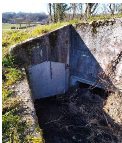
Entrée Sud du dalot sous la RD67 (crédit photo : Étienne Boissy)
